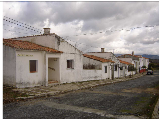
Casas de colonos. Fuente: elaboración propia.
