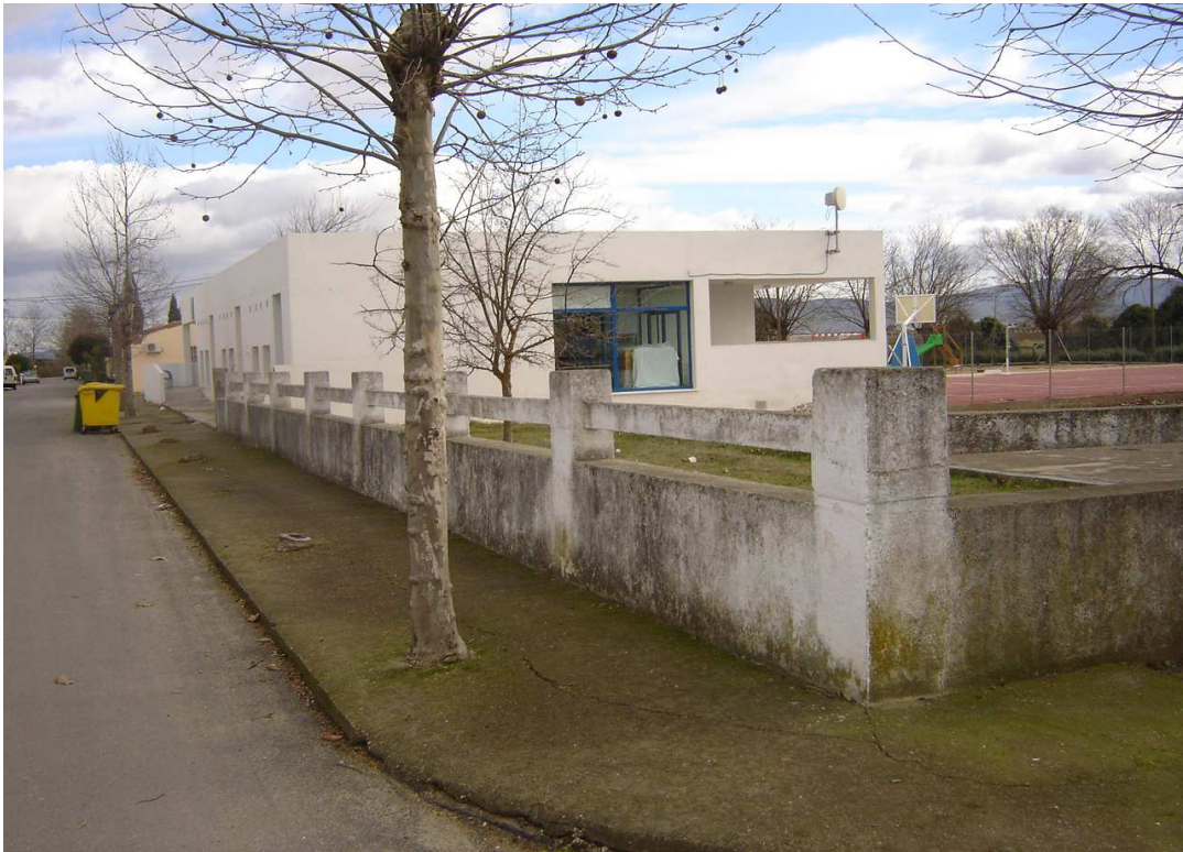
Escuelas de Valdencin. Elaboración propia.
