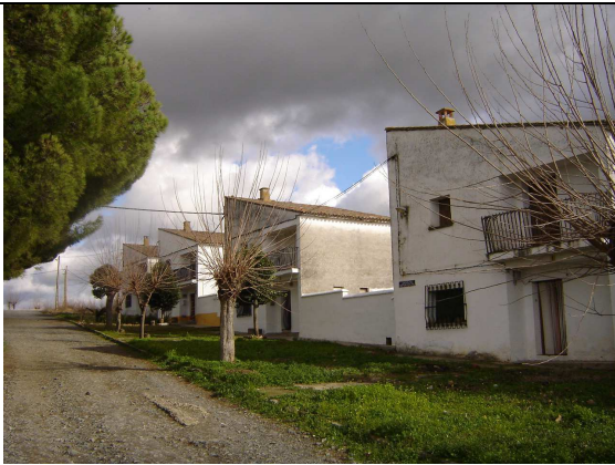
Casas de colonos. Fuente: elaboración propia
