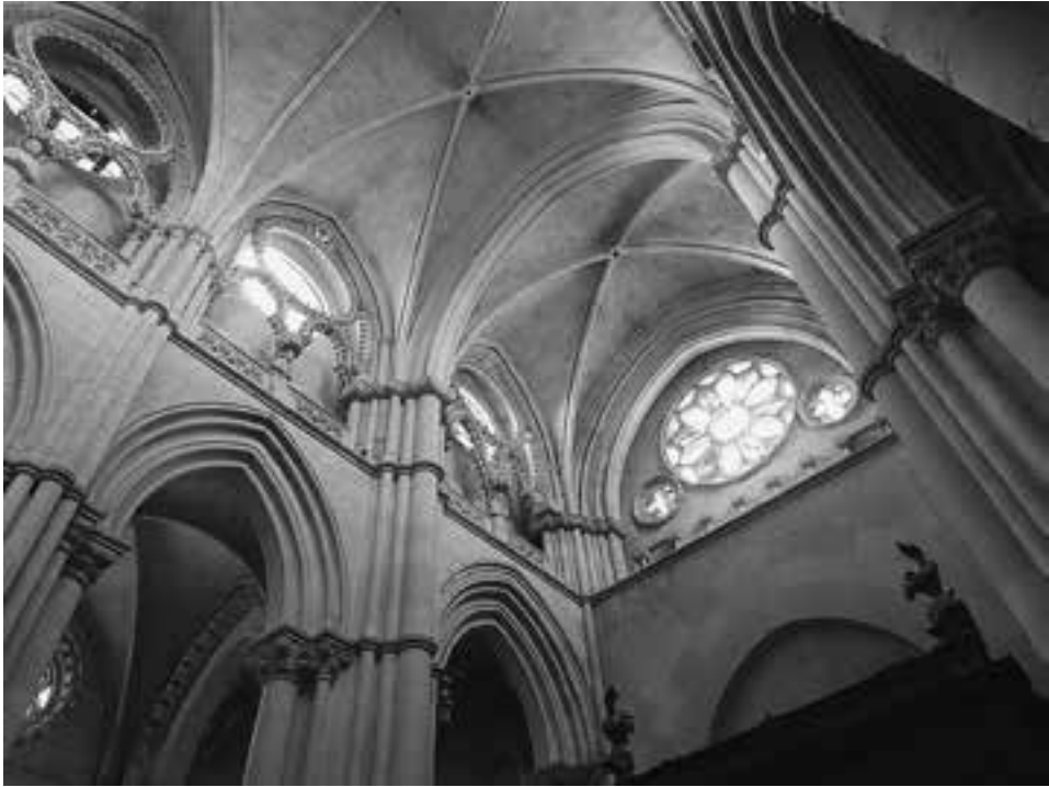
FIG. 6. Arco fajón que divide el primer tramo de la nave central de la Catedral de Cuenca. Fotografía de la autora.
