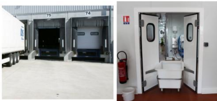
FIGURA 6.24. Puertas que incumplen Norma IFS Fuente: SGS (2014)
