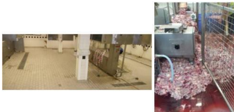
FIGURA 6.21. Suelos que incumplen Norma IFS. Fuente: SGS (2014)
