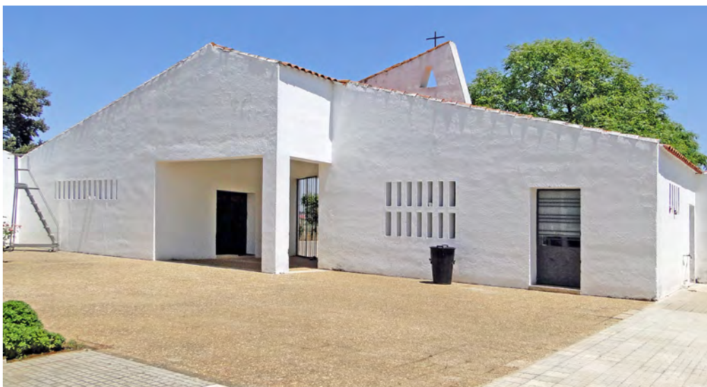
Figura 44. Valdebótoa. Acceso desde el interior.
