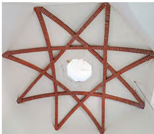
Figura 12. Cúpula de la capilla.
