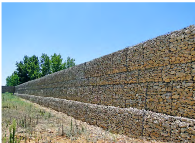
Figura 46. Ampliación de Valdebótoa. Muro de gaviones.
