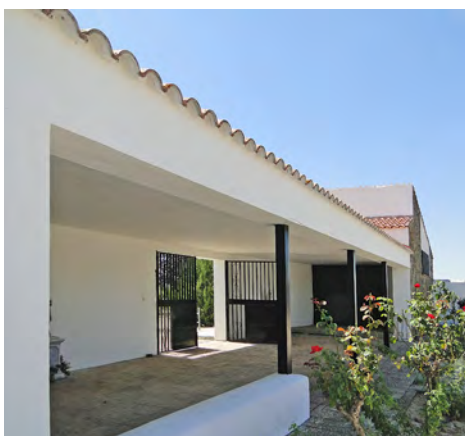
Figura 49. Valdehornillo. Porche y pilares.
