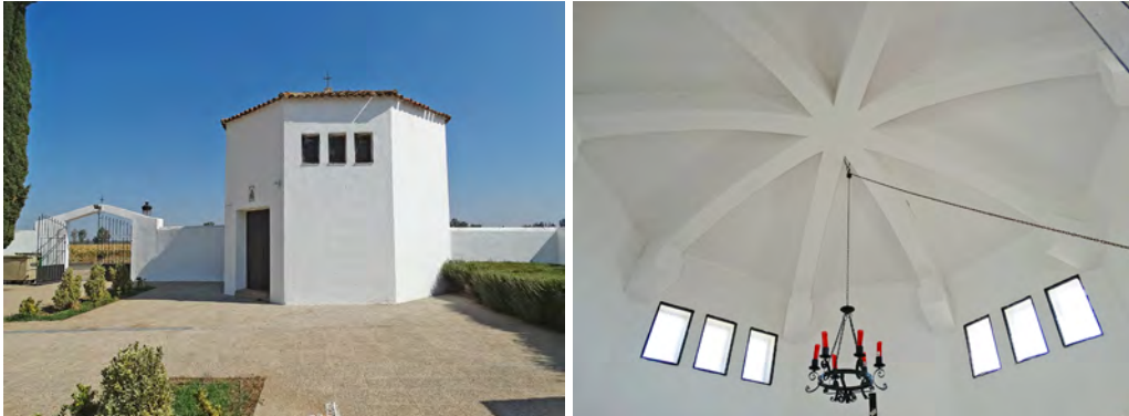
Figura 23. Balboa. Capilla. Exterior y cerramiento interior.
