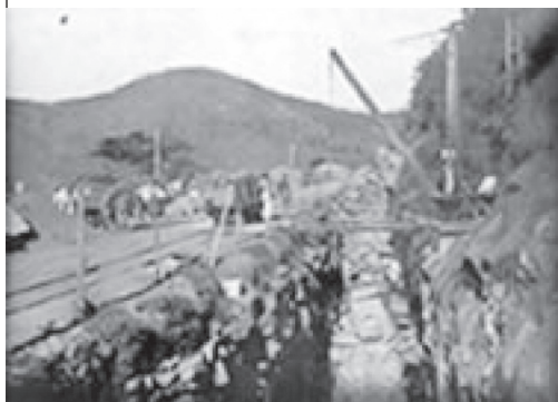
Figura 7 - Início da Construção da Barragem da Usina Marmelos Zero, 1888 (Foto : Museu Usina Marmelos Zenos da Universidade Federal de Juiz de Fora).
