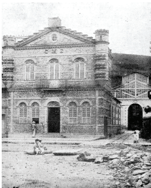
Figura 3 – Fachada da sede da Companhia Mineira de Eletricidade, 1915 (Foto: Museu Usina Marmelos Zero – Universidade Federal de Juiz de Fora)
