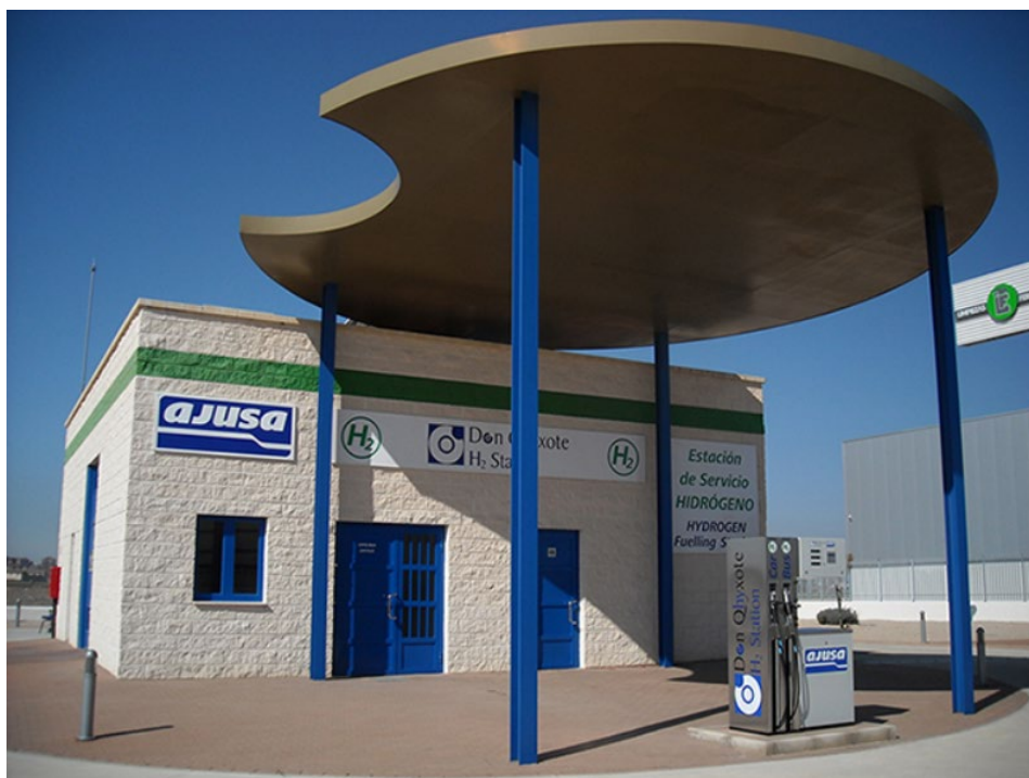
Figura 14. Estación de servicio de hidrógeno en Albacete. Fuente: Blog AJUSA
