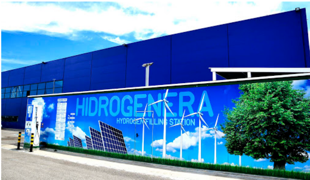
Figura 12. Estación de servicio de hidrógeno en Huesca. Fuente: PortFolio Walqa
