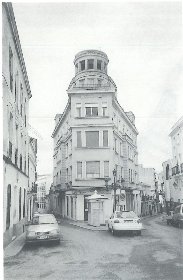
FIG. 3. Bloque de viviendas calles Trinidad y Doblados (1950).
