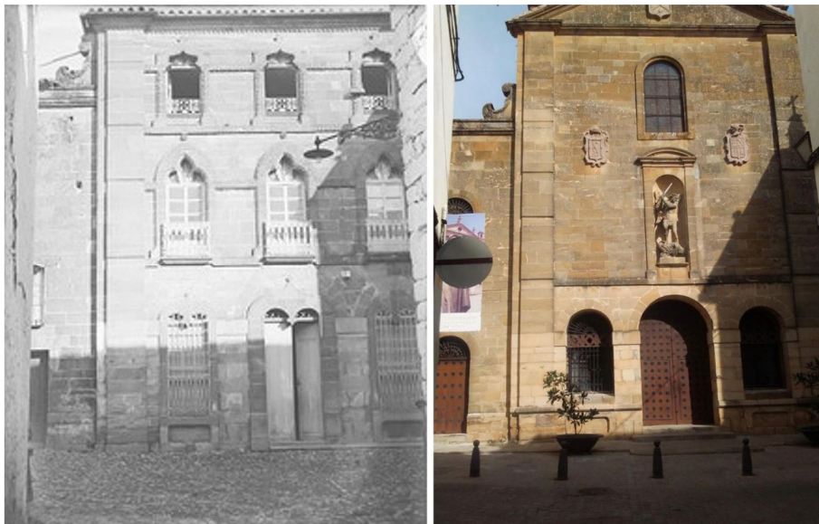
Fig. 3. Fachada del Convento de San Miguel, Úbeda (hacia 1920 y en la actualidad) [Fuente: colección particular / autor]
