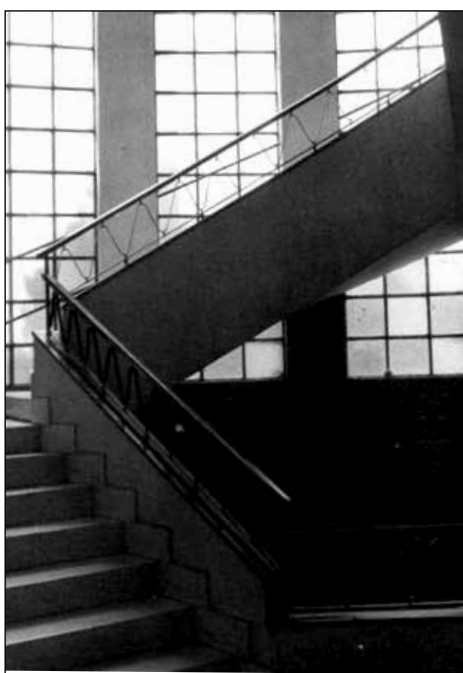
Escaleras laterales de la sección de Maestras.
