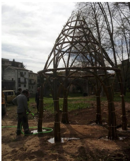
Imagen 3. Proceso de construcción de una estructura de plantas vivas con técnicas de cestería de Ona Trepat en Sant Joan les Fonts, Girona (febrero de 2017).
