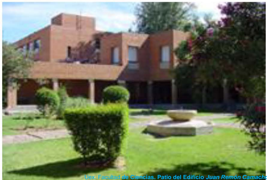
Uex. Facultad de Ciencias. Patio del Edificio Juan Remón Camacho
