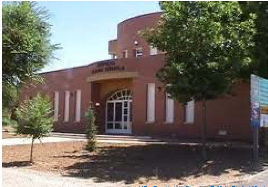
UEx. Facultad de Ciencias. Edificio Eladio Viñuela
