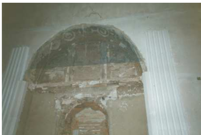
Altar central: Fase de restauración
