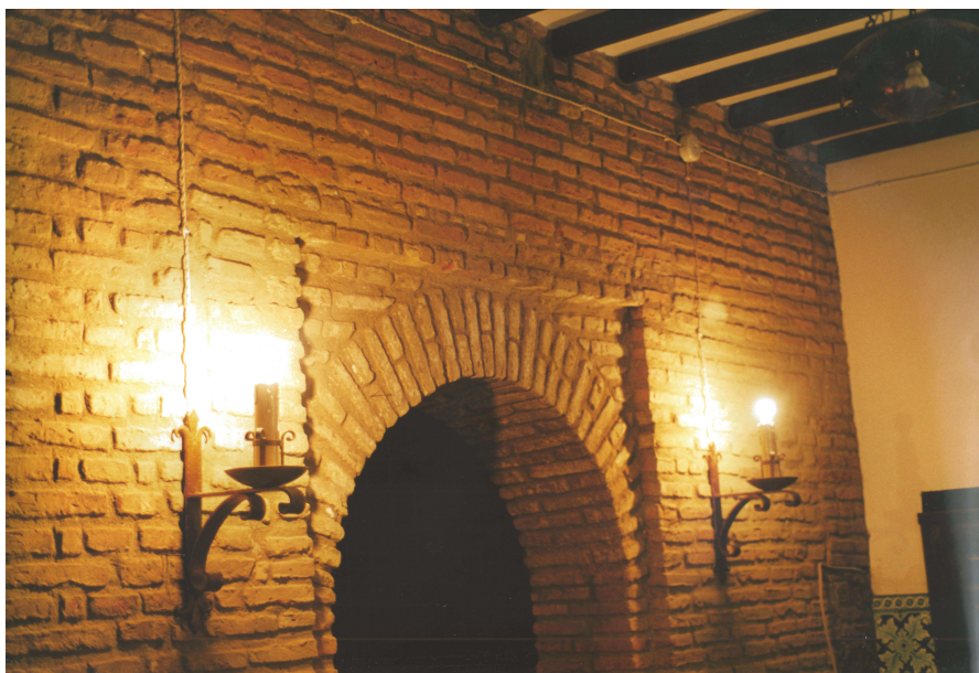
Fotografía de 2003. Muro Este de sacristía, cable trenzado, cajas de registro y luminaria
