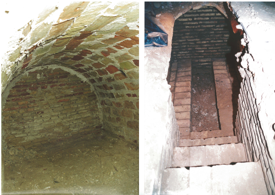
Fotografía 21. En proceso de restauración. A la izquierda con la cimbra retirada, a la derecha terminando los bancos laterales y entrada a falta de realización del suelo
