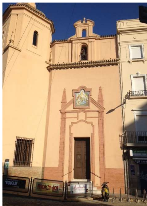
Fotografía 11. Fachada Sur, última restauración.
