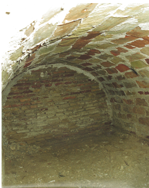
Fotografía tras el desmontaje de la cimbra
