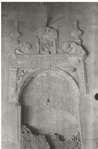
Fotografía 1955 altar Sur muro Oeste
