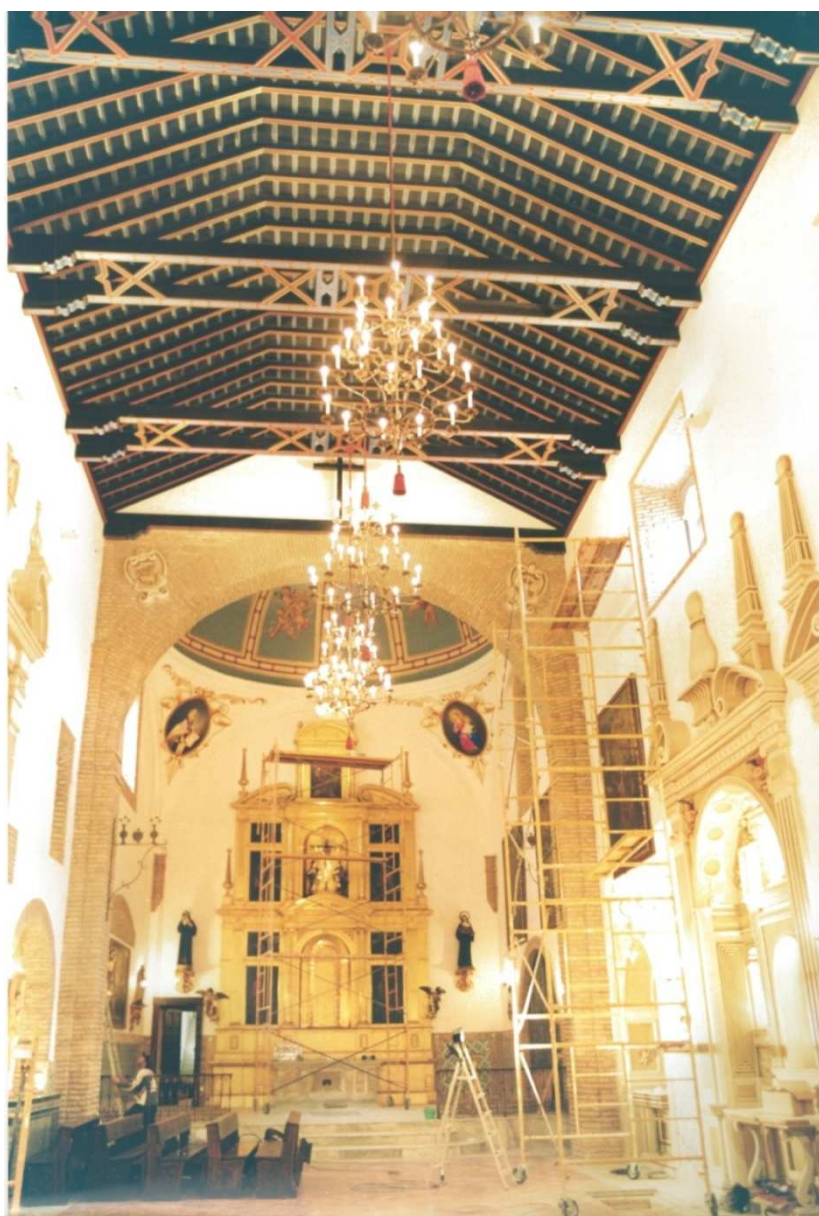
Fotografía 27. Vista de las obras en ejecución, al fondo el retablo y la cúpula, tomada días antes de la reapertura.
