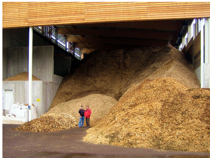
Figura 2.5 Almacén de biomasa cubierto (Fuente: multitekingenieros.com).
