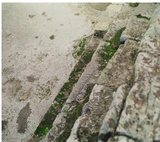
Foto 75: Pulvinium. Detalle del Caldarium. Termas de bulla Regia. Túnez. Fuente: M. Fraile
