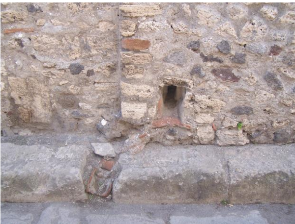
Foto 137: Desague de edificio a la calle. Pompeya. Fuente: M. Fraile
