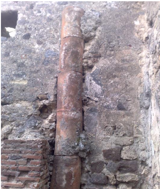
Foto 47 Conducción cerámica. Pompeya. Fuente: M. Fraile
