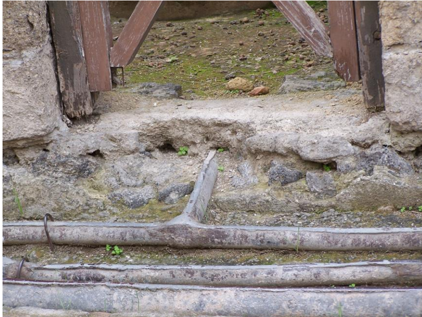
Foto 57: Conducción de agua en una domus de Herculano. Fuente: M. Fraile
