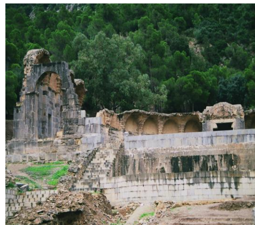
Foto 13 Templo de las aguas Zaghoan. Túnez. Fuente: M. Fraile
