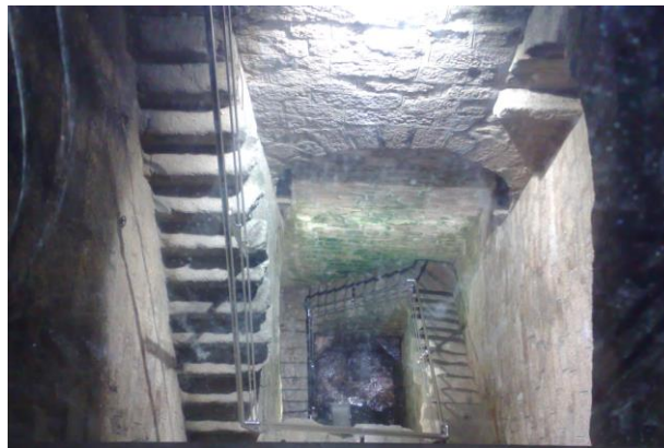
Foto 54: Presa Proserpina. Bocín de la presa. Fuente M. Fraile
