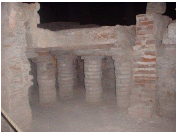
Foto 68: Suspensurae. Termas Gijón. Fuente M. Fraile
