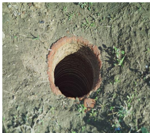
Foto133: -Tubería de conexión con la Cloaca. Sbeitla. Túnez. Fuente M. Fraile
