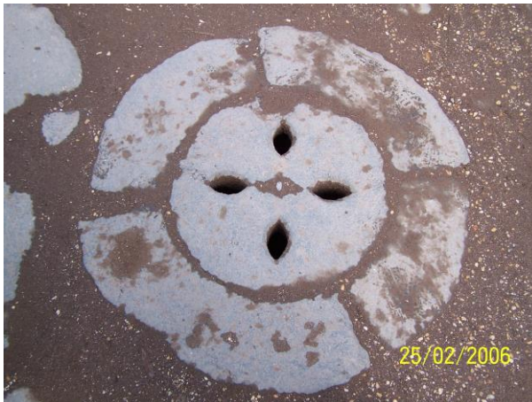
Foto 129: Alcantarilla. Fuente: M. Fraile
