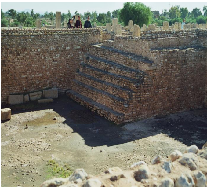
Foto 45 Castellum aquae. Sbeitla. Fuente: M. Fraile
