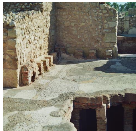
Foto 70: Detalle Hipocausto. Termas Sbeitla. Túnez. Fuente: M. Fraile
