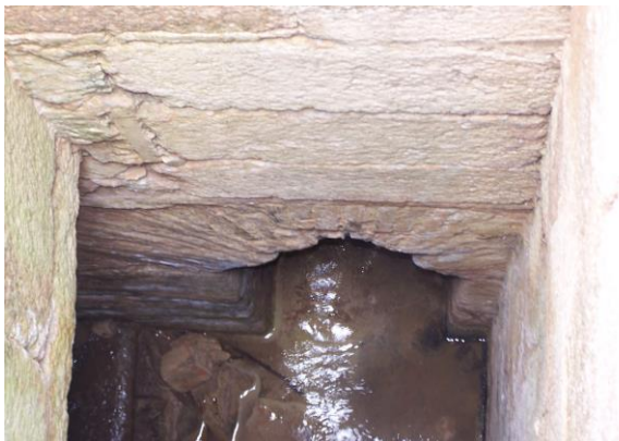
Foto 21 Conducción Rabo de Buey. Mérida. Fuente: M. Fraile
