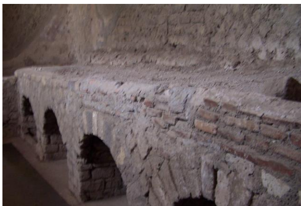
Foto 60: Cocina. Villa Ariadna. Italia. Fuente: M. Fraile
