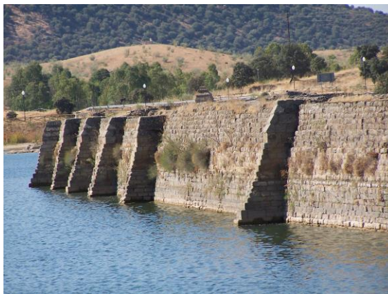
Foto 24. Presa Proserpina. Mérida. Fuente: M. Fraile
