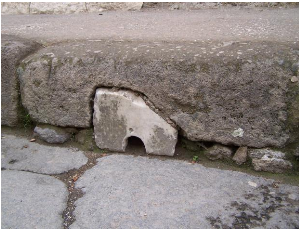
Foto 135: Desagüe en Herculano. Fuente: M. Fraile
