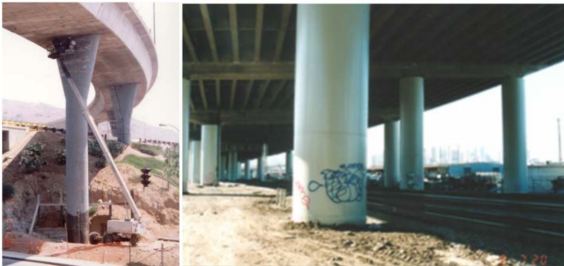
Figura 2.5 Pilares reparados mediante encamisados metálicos en Los Ángeles y San Francisco 5 .
