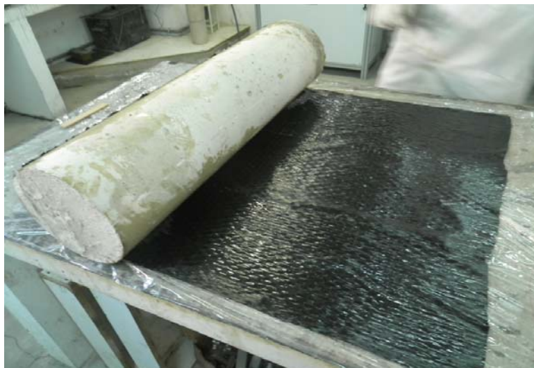
Figura 6.7 Ejecución de refuerzo directo de FRP, paso 2.
