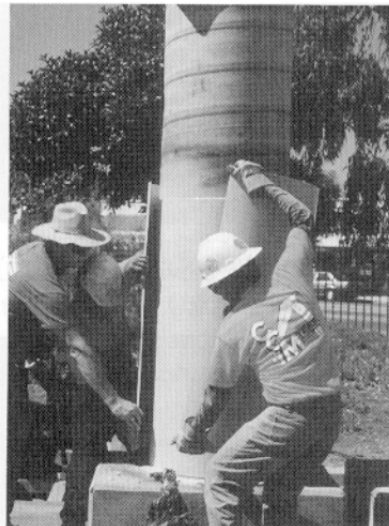
Figura 2.6 Técnica de refuerzo basada en encamisados prefabricados 1 .
