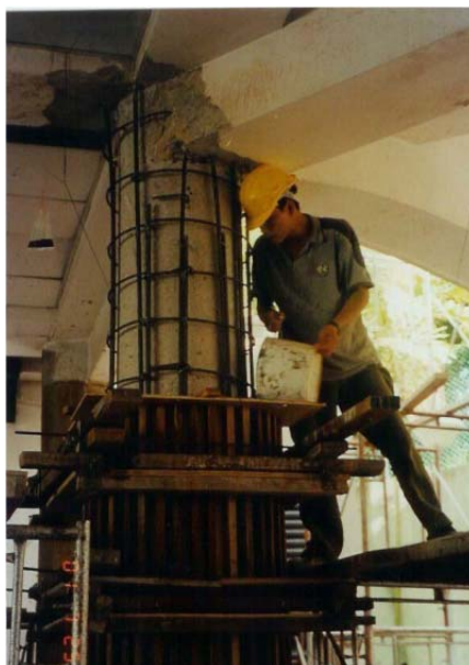
Figura 2.1 Vertido de hormigón - encamisados de hormigón armado 4 .
