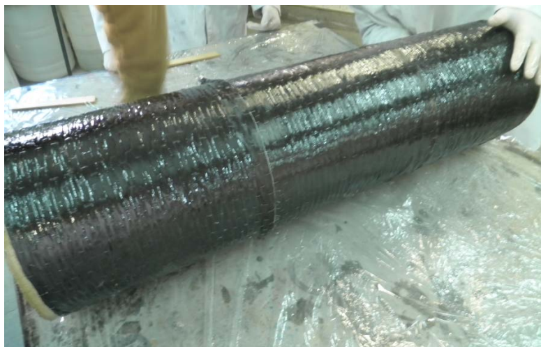
Figura 6.8 Ejecución de refuerzo directo de FRP, paso 3.
