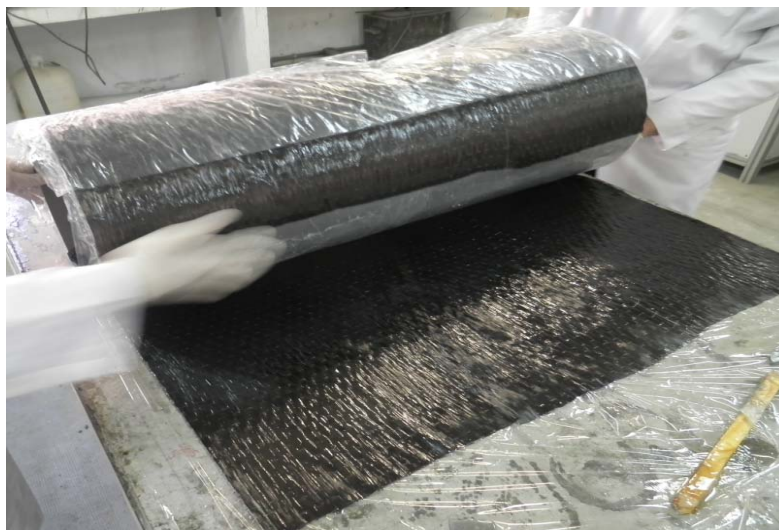
Figura 6.12 Fabricación de encamisados exteriores de CFRP, paso 2.
