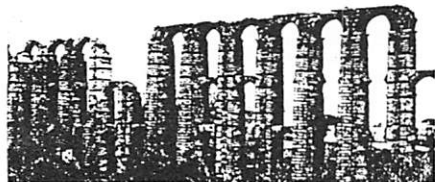
Así quedó el acueducto tras el derrumbamiento.
