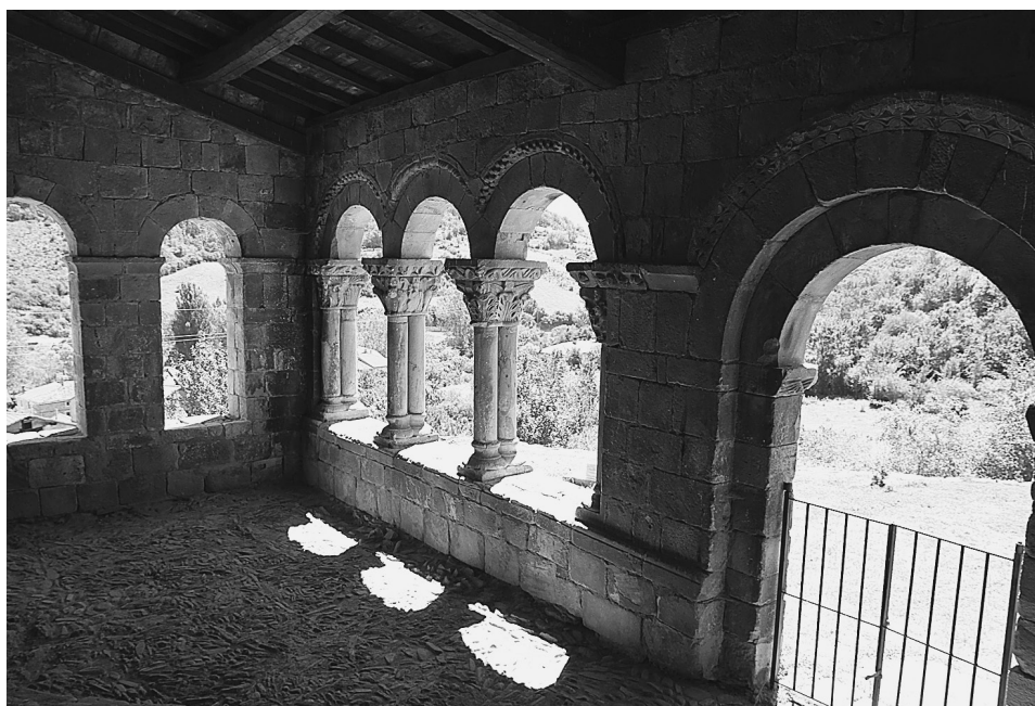
FIG. 5. Pórtico de Canales de la Sierra, La Rioja. Foto autor.
