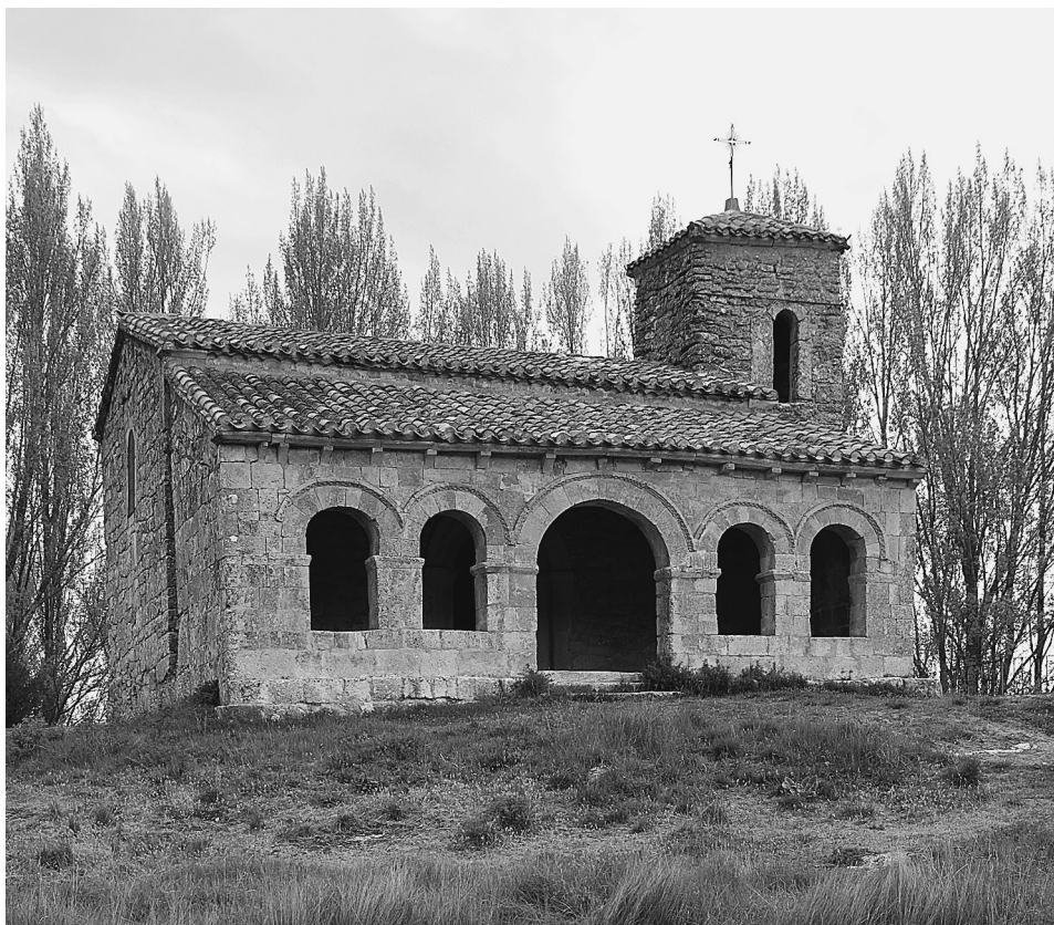
FIG. 1. Pórtico de la ermita de Santa Cecilia, Barriosuso, Burgos. Foto autor.
