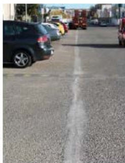
Figura 4.5: Sellado microzanja
