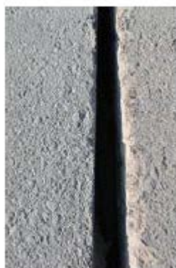
Figura 4.4: Microzanja
