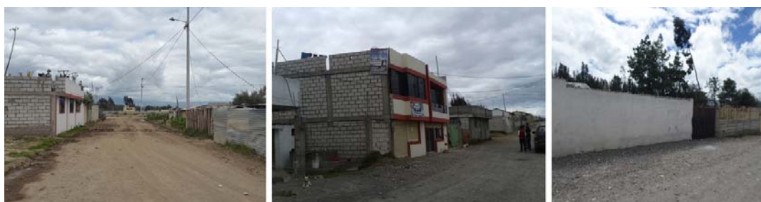
Figura 34. Estado de las vías sector periférico
