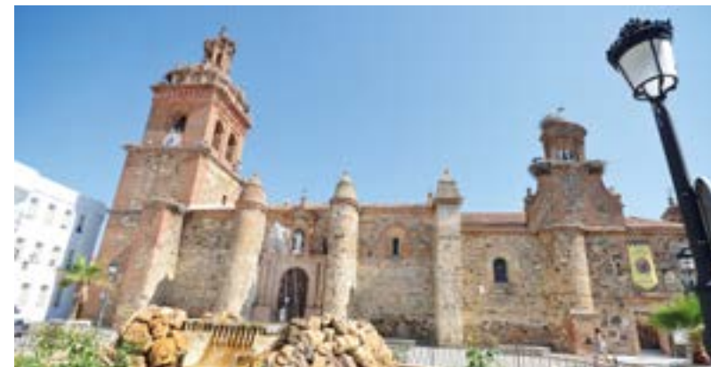
Fachada y detalle del campanario de la Iglesia de Santa Catalina
