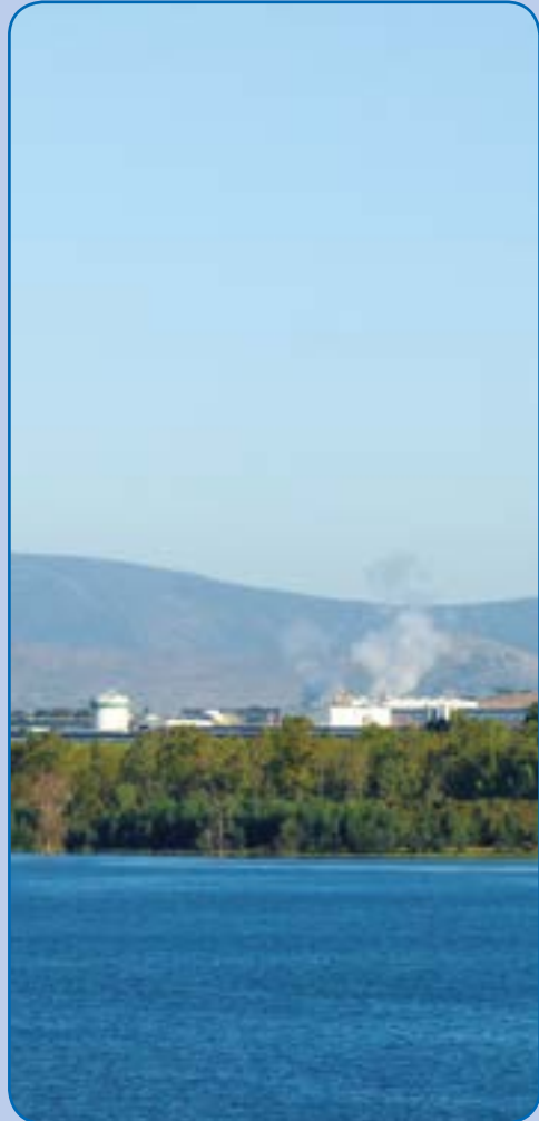
Plantas generadoras de energía
