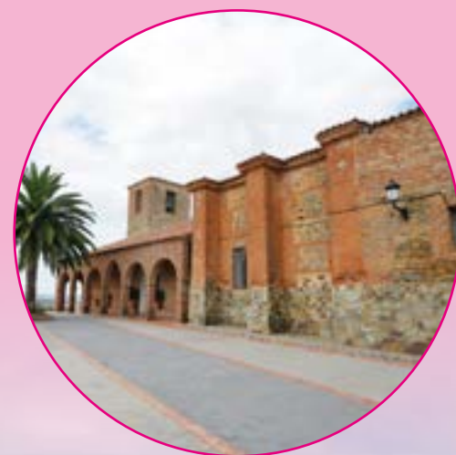
Fachada y vista general de la iglesia de San Cristóbal
