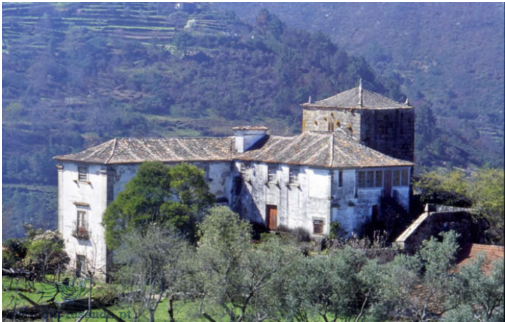
Fig. 10. Torre da Lagariça. 17
