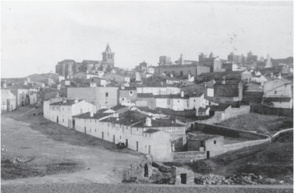
FIGURA 1 PUENTE VIEJO DE SAN BLAS DESDE LA CARRETERA DE TRUJILLO (1902). COLECCIÓN PARTICULAR.
