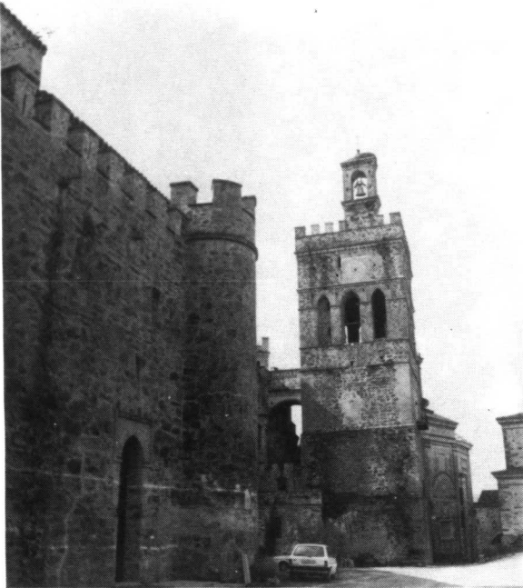
(Fig. 5) GUADALUPE. Monasterio. Torre de las Campanas y lado oriental de la cerca.
