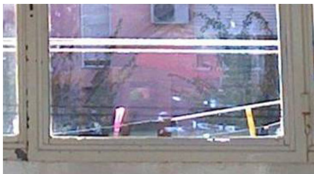
Figura 2. Ventana con perfiles de acero (C-09).
