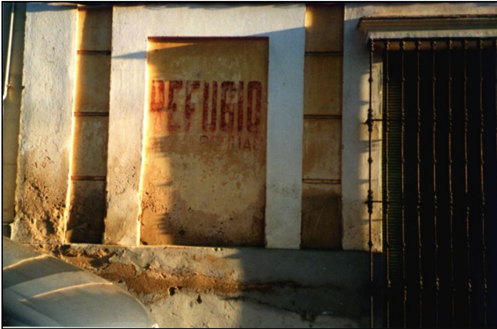
IMAGEN 4. Letrero que identifica un refugio en una casa, ya derruida, de la calle Villanueva.
