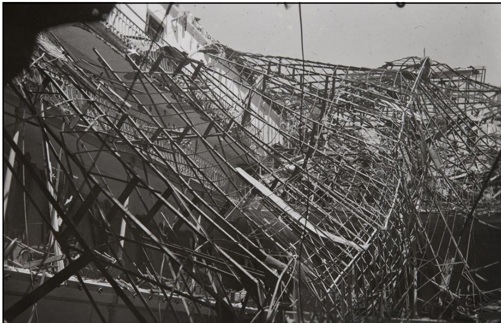
IMAGEN 5. Aspecto de la armadura del techo del "Viejo Teatro del Hospicio", hoy derruido, tras ser bombardeado.
