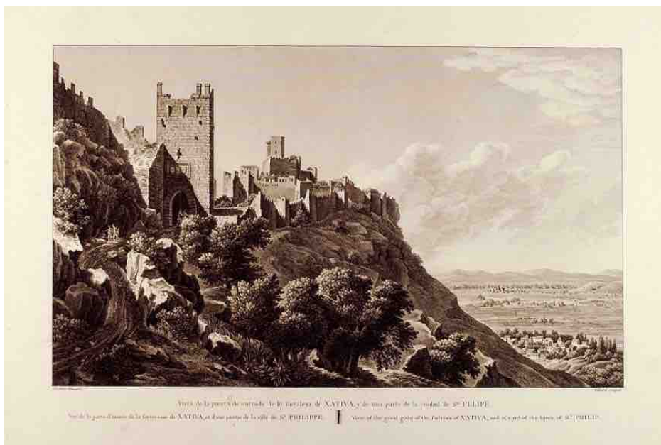
Fig. 5. Vista de la puerta de entrada a la fortaleza de Xàtiva. Gravado de Jean-Baptiste Tillard, publicado en Laborde, 1806-1820. Foto: Biblioteca Valenciana Nicolau Primitiu.
