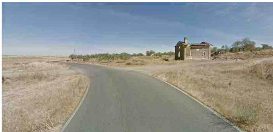
Fig. 12. Casilla de Guarda, en las cercanías de Valverde de Llerena; la actual carretera EX309 discurre paralela a la traza de la vía, visible en el territorio. En la parte inferior, otra casilla en el mismo municipio; en este caso se observa la traza que cruza, con una zona en trinchera a la derecha de la imagen (Google Street View)
