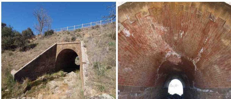
Fig. 17. Pontón de 4 m sobre el arroyo Sotillo, junto a Fuente del Arco. Hoy sigue en servicio, como parte de la traza de la vía verde La Jayona. Destaca el interior de la bóveda, de ladrillo visto y remates en sillería, que sorprenden aún por la albañilería
