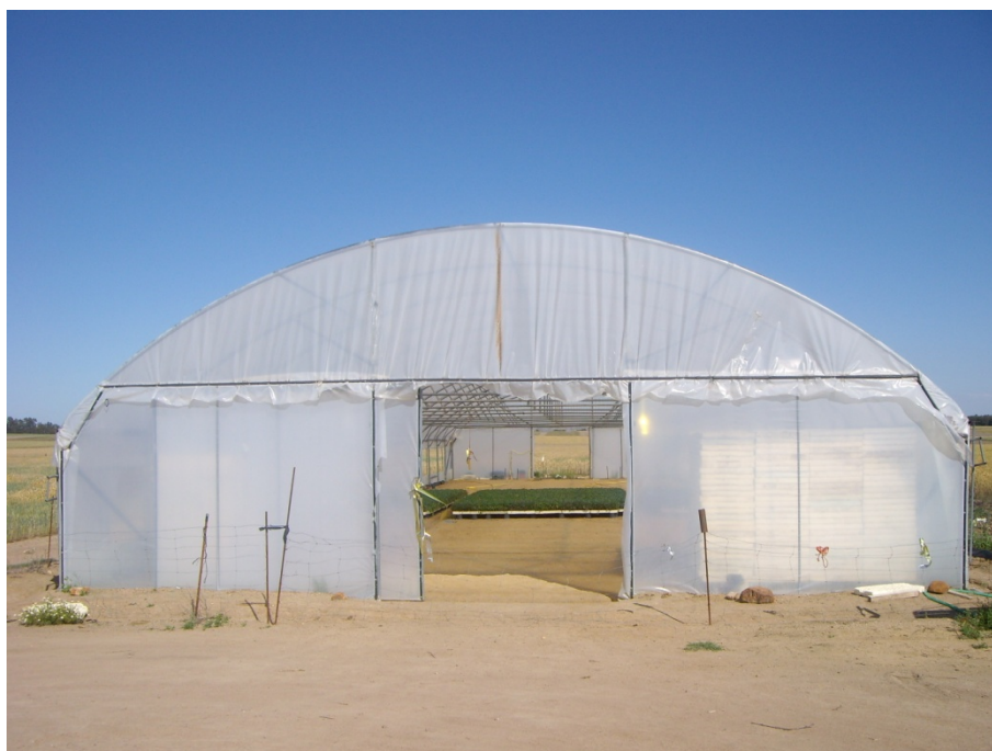
Figura 6. Invernadero tipo túnel simple de plástico flexible. (Fuente: elaboración propia).
