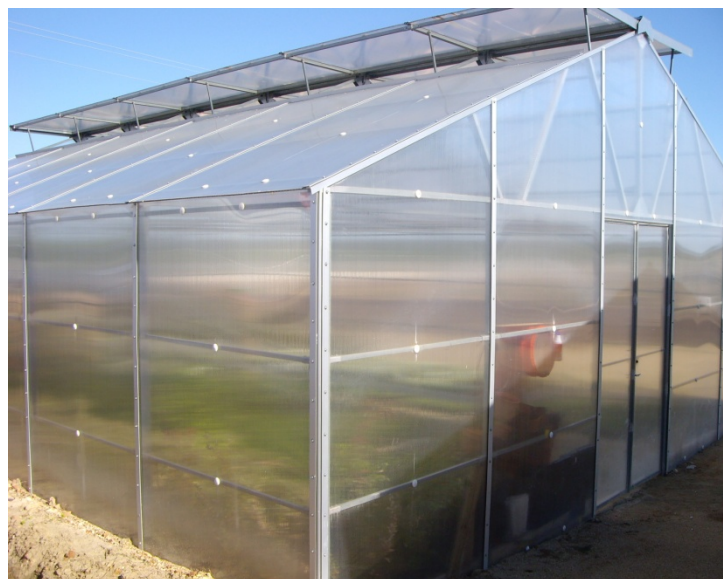
Figura 5. Invernadero tipo capilla de plástico rígido. (Fuente: elaboración propia).
