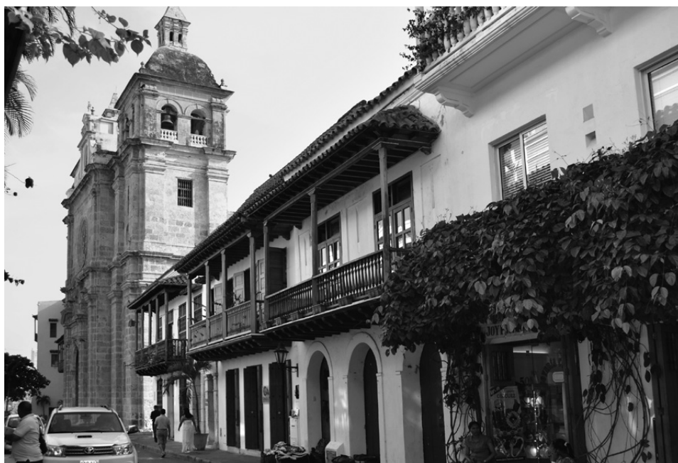
FIG. 2. Casas de dos pisos con balconada sobre canechillos de madera. Fotografía S. Garcés 2014.
