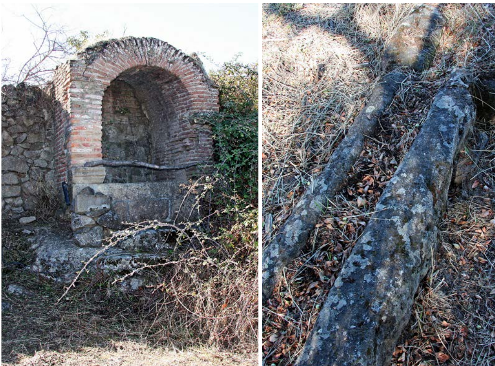
Figura 10. Santa Cruz de la Sierra. Huerta del Convento de San Joaquín: Pozo junto a la valla oriental, posiblemente el que originó las disputas con los vecinos y restos de una de las canalizaciones de piedra berroqueña.
