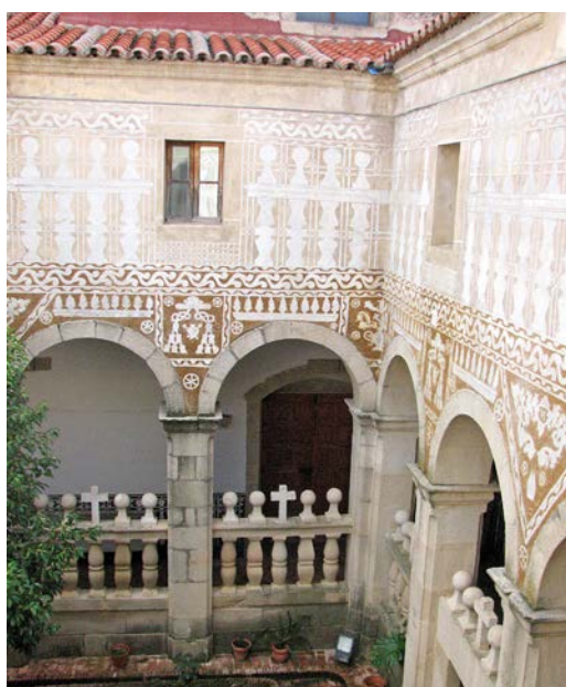
Figura 19. Valdefuentes. Claustro del antiguo convento del Dulce Nombre de Jesús, actuales dependencias del ayuntamiento de la localidad.
