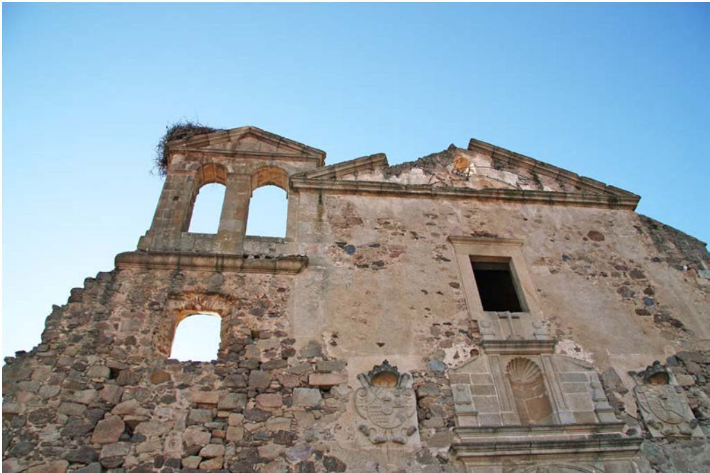
Figura 2. Santa Cruz de la Sierra. Fachada de la iglesia del Convento de San Joaquín.
