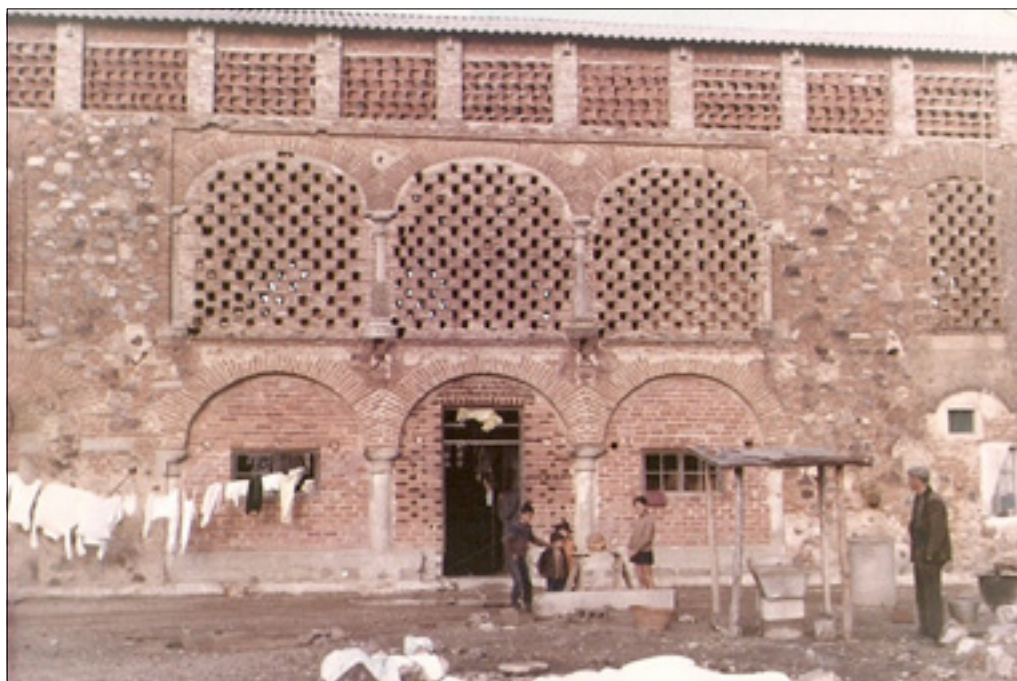
Figura 17. Claustro del convento de San Juan Bautista.
