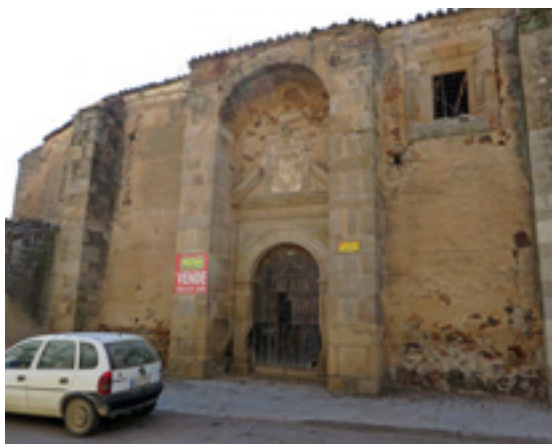
Figura 12. Iglesia del convento de San Juan Bautista.
