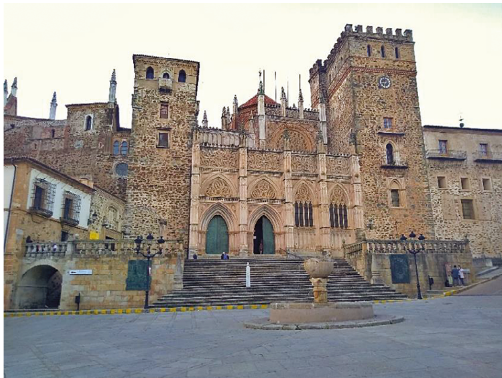
Figura 5. Fachada principal del Real Monasterio de Santa María de Guadalupe, Guadalupe (Cáceres).
