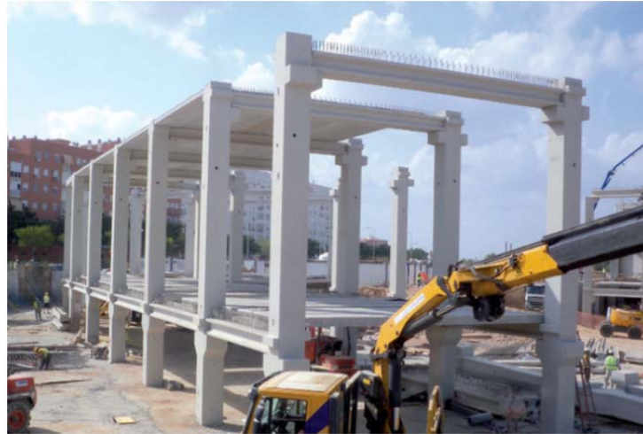
Figura 3.12- Uso del cemento en obras prefabricadas según su catálogo (Foto CIMPOR, Obra Bogaris PRAINSA)
