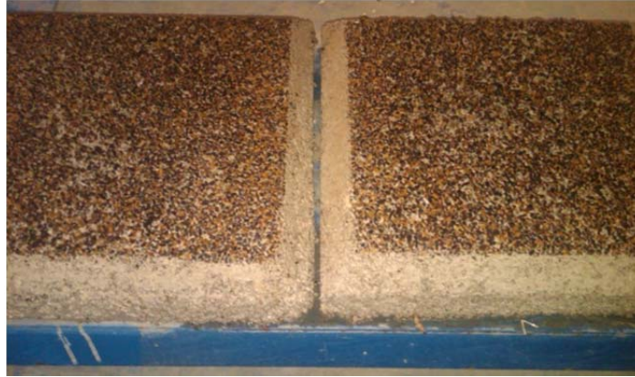
Figura 3.9- Baldosas con presencia de ataque superficial para dejar al aire los granos de corcho con misión estética y aislante (Foto Alberto Escalera)
