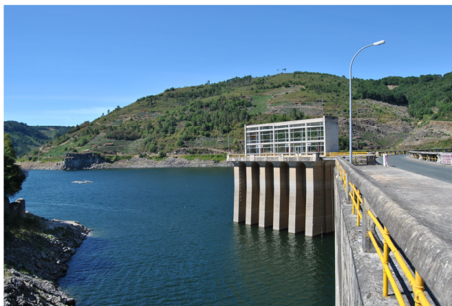
Fig. 7. Edificio de control de Belesar. © Begoña Fernández Rodríguez.
