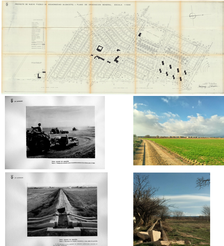
Figura 5. Aguas Nuevas antes (a la izq. Fuente: Mediateca-MAPAMA) y ahora (a la drcha. Fuente: fotos del autor). 1. Plano urbano. Fuente: Delegación de Agricultura de Albacete - Junta de Comunidades de Castilla-La Mancha. 2 y 3. Nivelación de suelos y campos de cultivo 4 y 5. Acequias y canales de riego.
