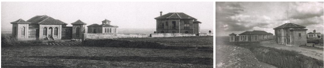
Fundación González Allende. Escuela maternal, cantina, viviendas y grupo escolar. Toro. 1914 60. Disposición del conjunto de pabellones. 61. Los tres Pabellones en los años 20.
