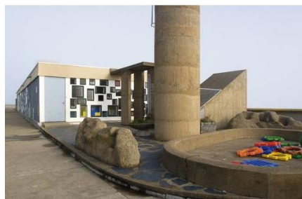
276-277. Unité d'habitation de Nantes-Rezé. 1953.
