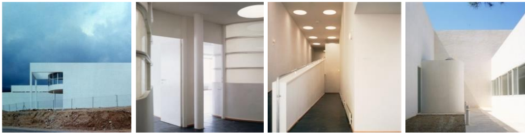
6-9. Guardería Infantil. Arquitecto: Alberto Campo Baeza. Onil (Alicante). 1982.
