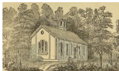
813-815. Escuela en Centremill, North Providence, Rhode Island. Arquitecto: Tefft.
