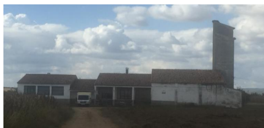
87. Capilla-Escuela en la finca de “La Mata Baja” en el término municipal de Vegaviana. José Luís Fernández del Amo. 1967. Vista exterior actual.
