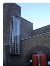
322-324. Nassauschool. Groningen. Arquitecto: S. J. Bouma. 1931.
