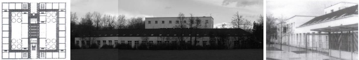
79-81. Ikastola. Arquitectos: Linazasoro y Garay. Hondarribia (Guipúzcoa). 1974.
