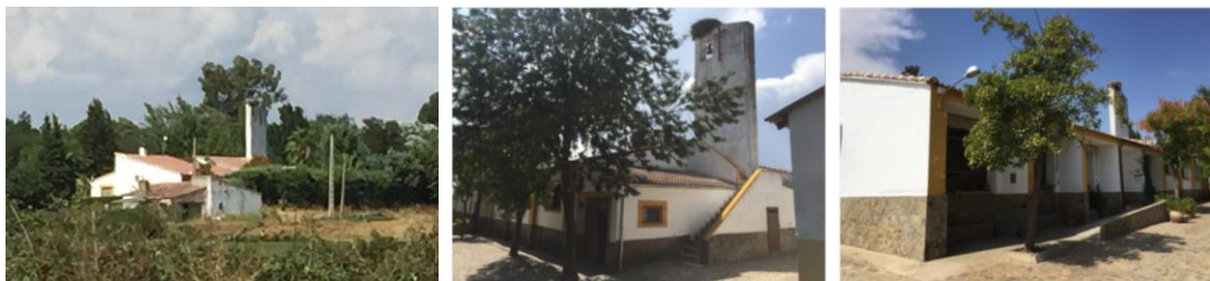
72-74. Capilla-Escuela en la finca de "Rozacordero" en el término municipal de Moraleja. Arquitecto: José Luís Fernández del Amo. 1967. Vistas actuales.
