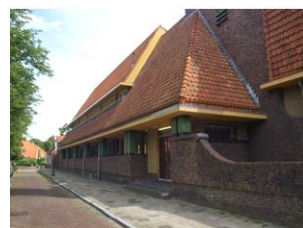
310-312. Simon van Hasseltschool. Arquitecto: S. J. Bouma. 1926.
