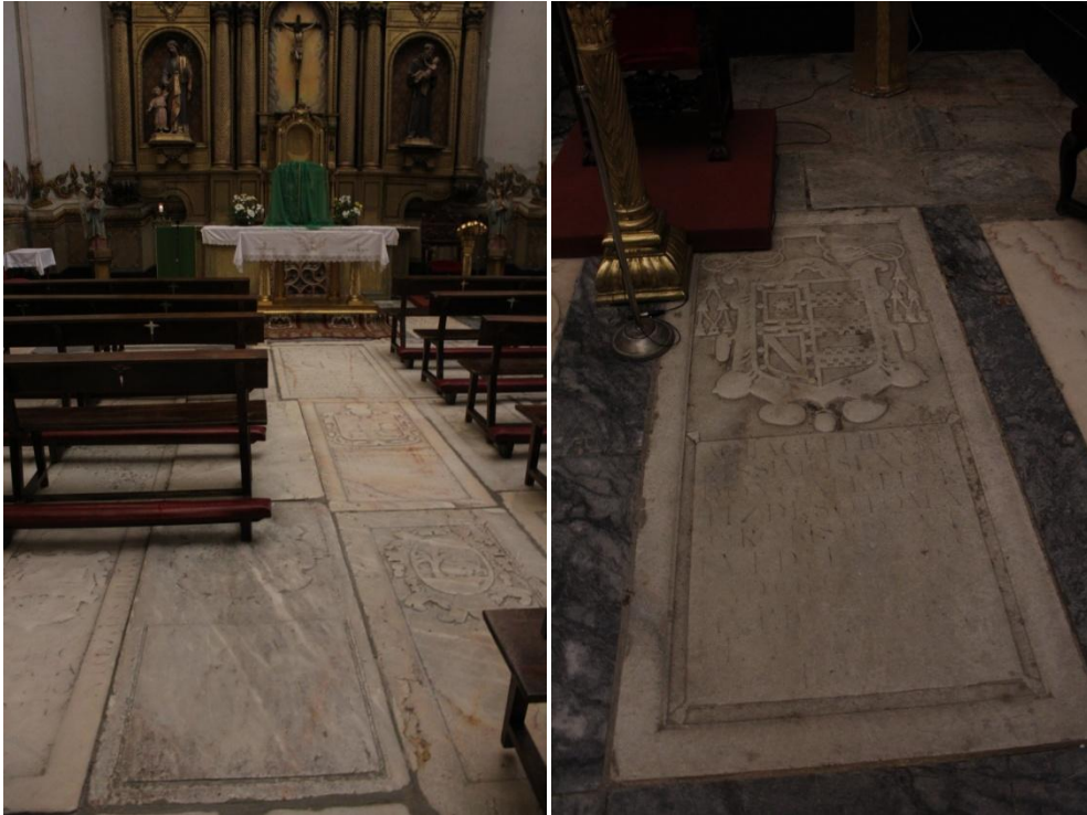
Figura 48. Vista general del pavimento de la capilla del Sagrario, catedral, Badajoz.
