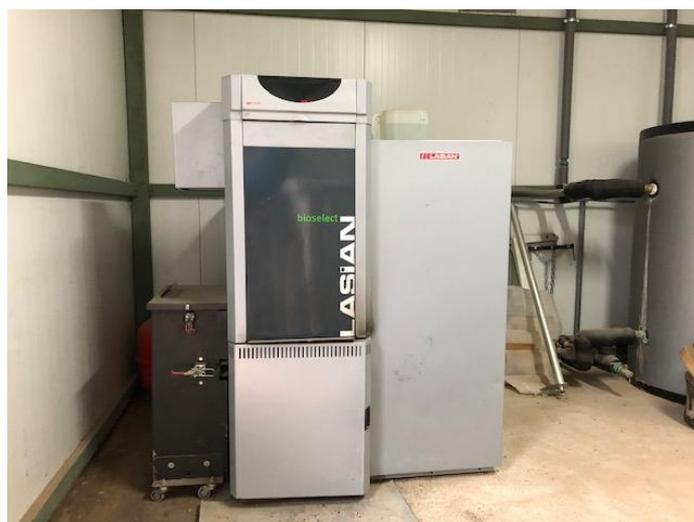
**Figura 21. Caldera Lasian Bioselect Compact 30 para producción de calefacción en los invernaderos de Cicytex.**
