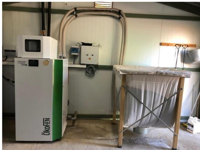
**Figura 19. Caldera Ökofen Pellematic Condens para producción de calefacción y electricidad en los invernaderos de Cicytex.**
