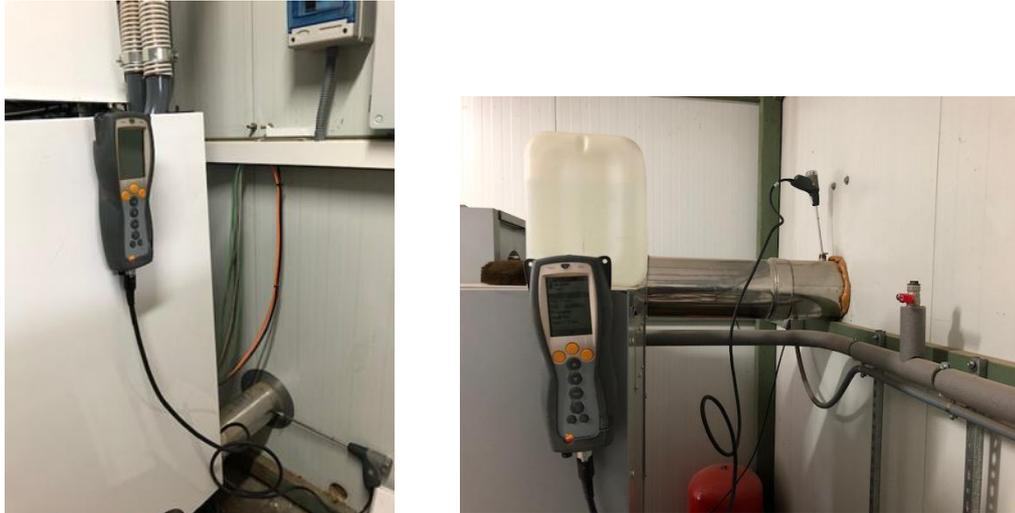
**Figura 23. Seguimiento del proceso de combustión mediante analizador de gases portátil Testo en ambas calderas.**
