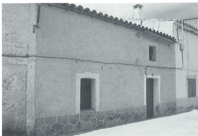
FIG. 13. Vivienda transformada y enfoscada para adecuarse a los nuevos tiempos (Solana).
