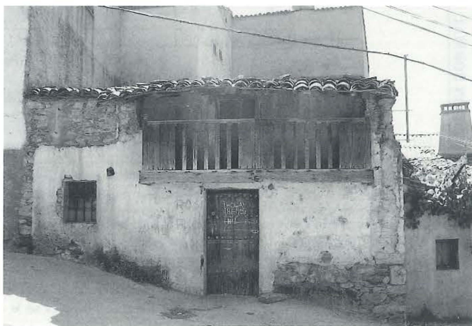
FIG. 10. Uno de los pocos ejemplos de solana corrida sobresaliente en la comarca (Roturas).
