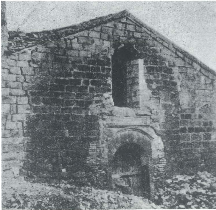
FIG. 6. Fachada sin restaurar de la iglesia de Palma de Ebro (MARTINELL, C., 1935).
