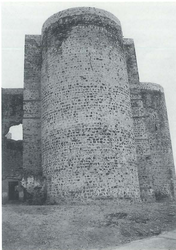
FIG. 1. Torre del Homenaje del castillo de Villalba de los Barros. Podemos apreciar en la parte superior el recrecido perimetral correspondiente al pretil, reconstruido gracias a las huellas de arranque que aún conservaba.
