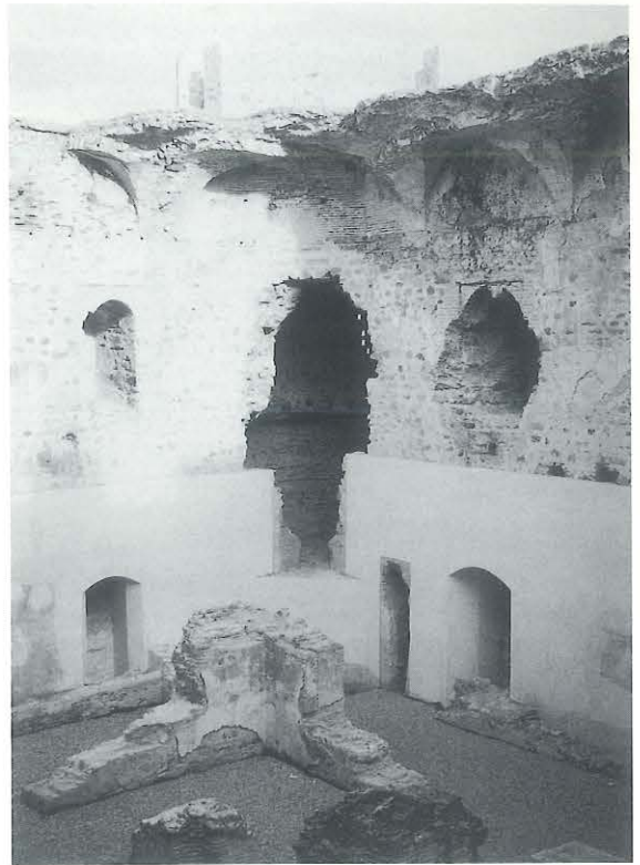
FIG. 3. Perspectiva interior de la fortaleza. El hueco del fondo corresponde a una de las torres semicilíndricas vaciadas en los trabajos de restauración. Es posible apreciar también el ángulo de las crujiás que determinarían el espacio interior, realizadas en mampostería y ladrillo encalado.
