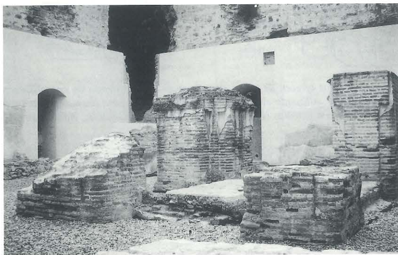
FIG. 6. Detalle del cuerpo central en torno al cual se levantarían las crujías del interior del castillo. Los materiales empleados son típicamente mudéjares: ladrillo enjalbegado. Algunos de estos machones conservan restos del arranque de sus arcos, probablemente de herradura. El paramento blanco del fondo correspondería a la fábrica primitiva de tapial oculta por los escombros en el momento previo a la restauración, al igual que el cuerpo central comentado.
