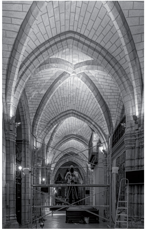
2 Estructuras montadas para la realización de las reproducciones
