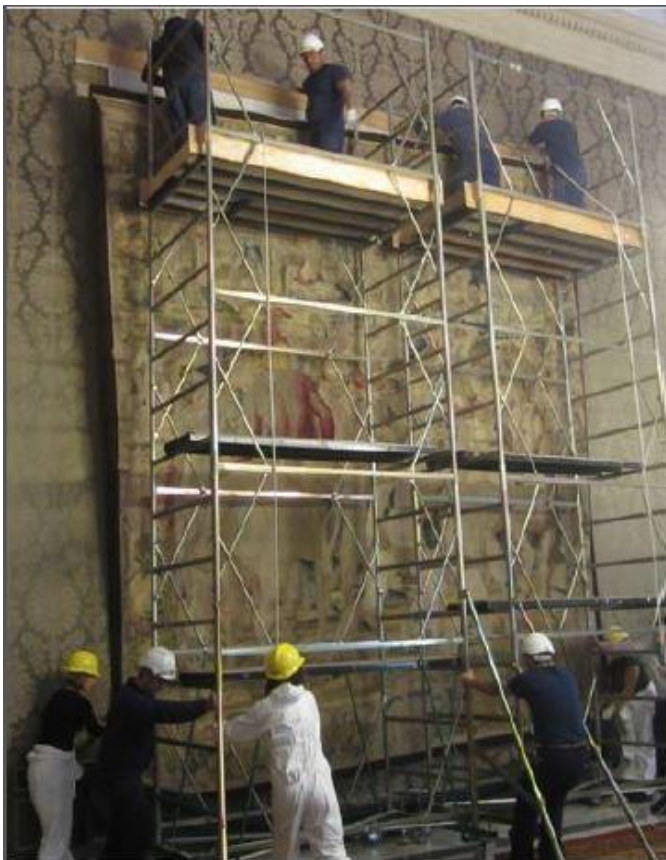
Fig. 6: Instalación de un tapiz. Palazzo del Quirinale (Roma).
