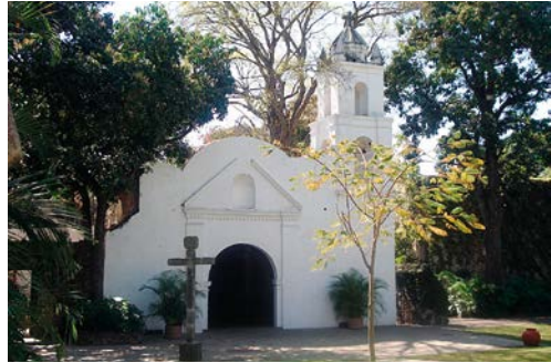
Fig. 9: Fachada de la capilla de la hacienda.
