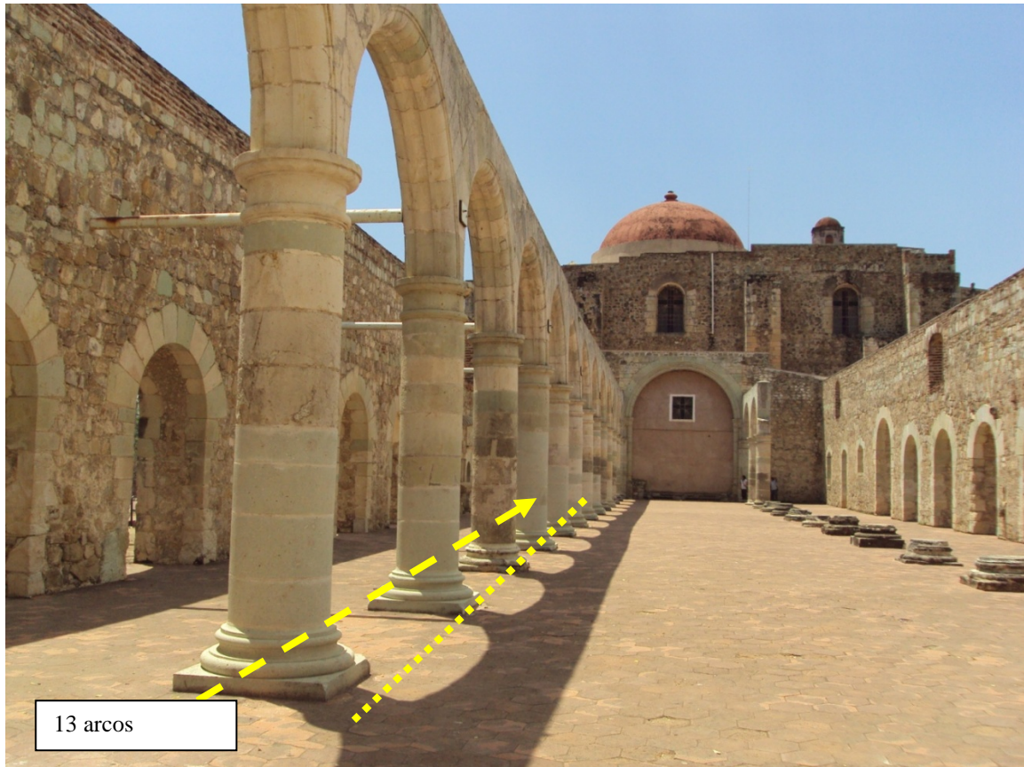
Fig. (121) Arcada interior del Templo menor de tres naves con muro que cierra el espacio de entrada a la antigua Capilla abierta
