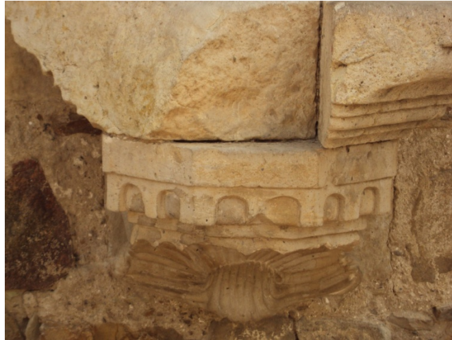
Fig. (124) Base del púlpito con detalle decorativo y concha en la parte inferior
