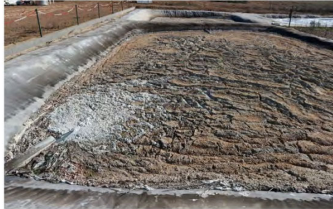
Figura 2. Lagoa de armazenamento do efluente proveniente de queijaria
