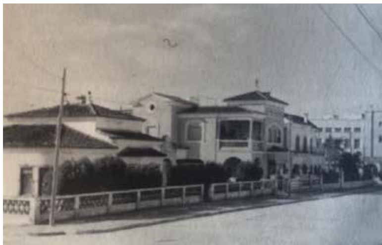
Figura 24. Chalets de la Avenida de Santa Marina.
