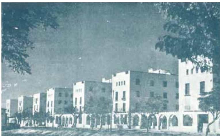
Figura 14. Las obras de las viviendas. Revista Mundo Ilustrado año XXX, 1951. Imagen aportada por Francisco J. García Ramos.
