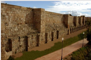
Figura II.1.0.25. Dique romano, construido en el siglo I a.C. para contener las crecidas del río Guadiana. Actualmente puede contemplarse el tramo que va desde el puente romano hasta la calle Atarazanas. En su parte inferior se aprecian desembocaduras de cloacas. Sobre el dique se construirá posteriormente el muro de cerramiento de la alcazaba islámica.
