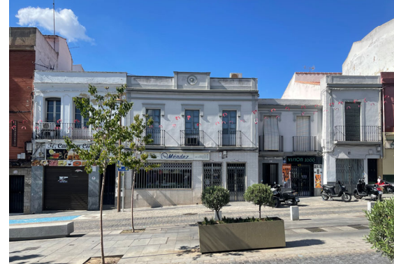
1a. C/Puente nº16 a 22.
