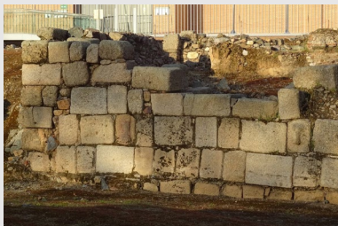
Figura II.1.1.1. Refuerzo de sillares en Morería
