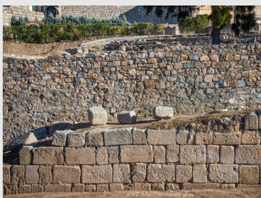
Figura II.1.1.2. Refuerzo de sillares en la Alcazaba.
