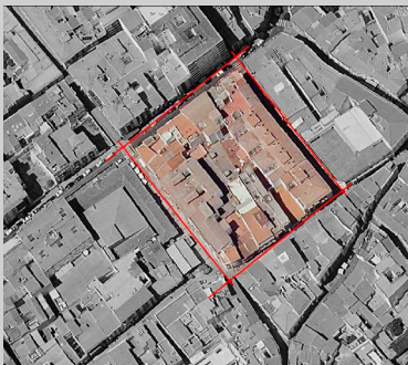
Figura II.2.4.8. Vista aérea de la manzana M20. Se han marcado los ejes de las vías romanas adyacentes. Fuente: Elaboración propia sobre Ortofoto PNOA 2022.
