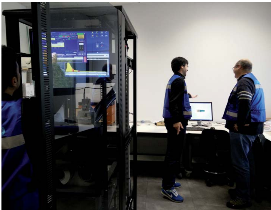
En los laboratorios de Alerta2 se ponen a punto nuevos sistemas de monitorización.
