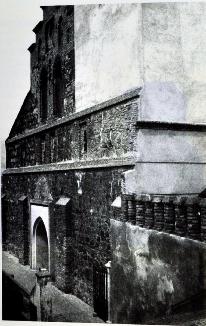
Fachada oeste de acceso al templo en donde se han consolidado las ventanas de clara tradición mudéjar y la torre campanario adosada a un extremo de la portada.
