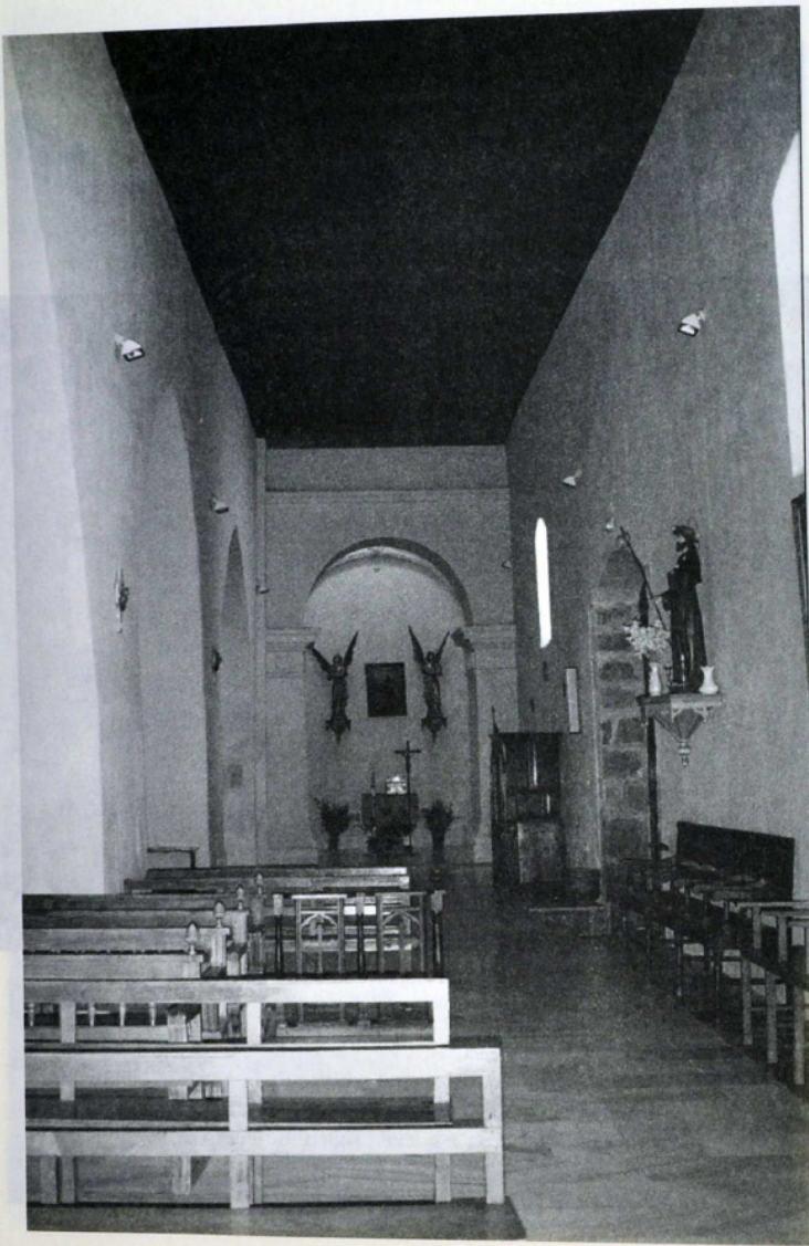
Nave del evangelio con la restauración completa de la armadura de madera descubierta tras la eliminación de la bóveda que la cubría, producto de una remodelación efectuada en el templo.
